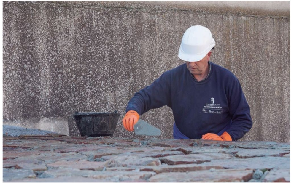
Los alumnos del programa mixto de formación y empleo realizan el solado de piedra de pizarra en el escenario ubicado en el patio del centro cultural Fonseca.
