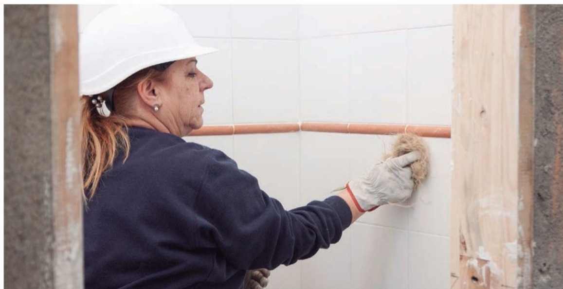
Una alumna realiza el acondicionamiento de los futuros baños accesibles.
