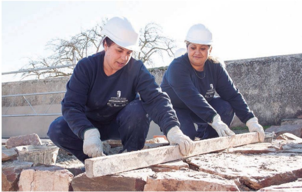
Los alumnos del programa mixto de formación y empleo realizan el solado de piedra de pizarra en el escenario ubicado en el patio del centro cultural Fonseca.
