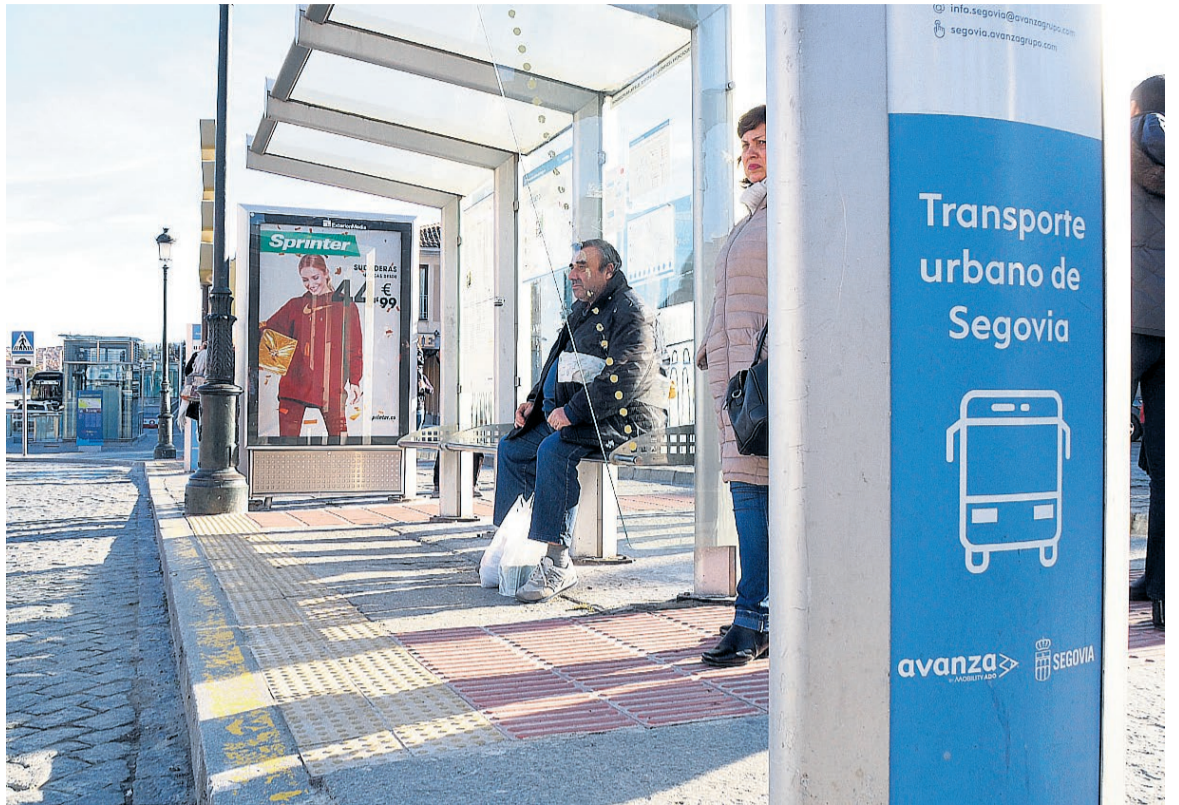
Imagen de las nuevas baldosas abotonadas y con guías instaladas en las marquesinas.
