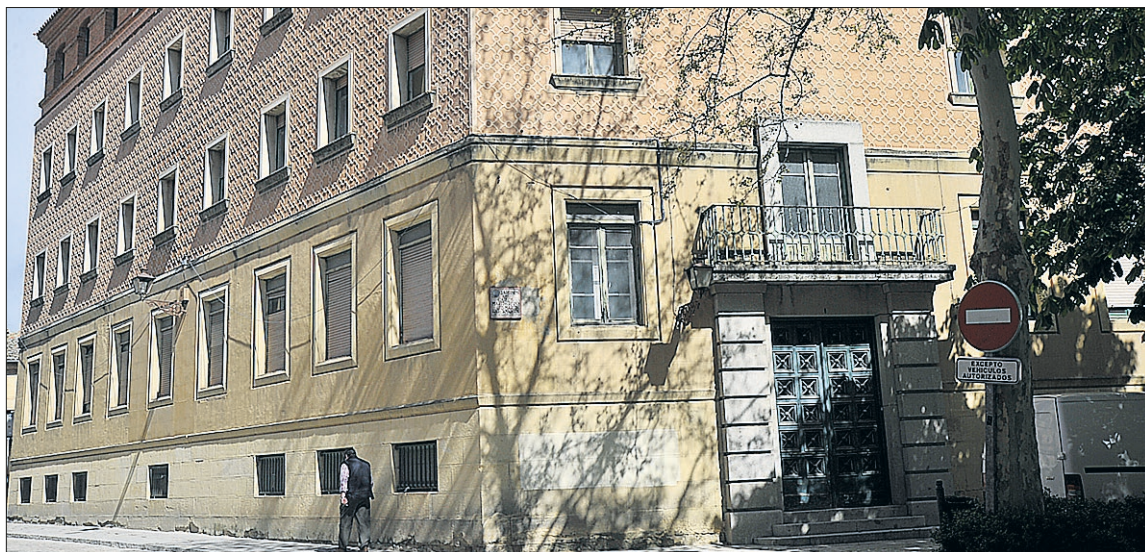
Fachada del edificio del Hospital Policlínico, situado en el recinto amurallado de la ciudad. / KAMARERO
