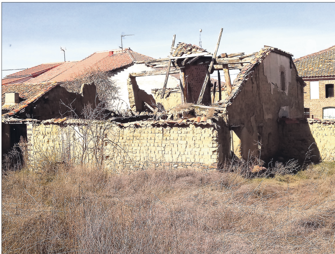
Antigua casa donde se va a instalar el museo.
