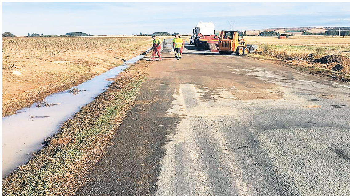
Uno de los equipos del servicio de vías y obras de la Diputación, realizando ayer tareas de limpieza. / EL ADELANTADO
