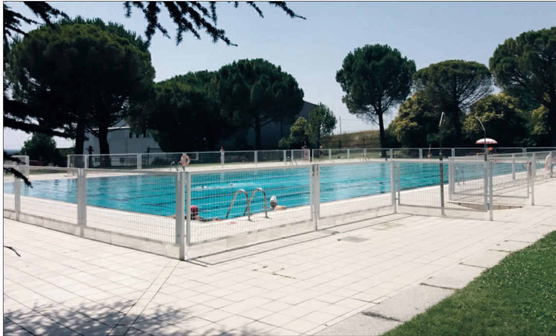
Trabajos de impermeabilización realizados en la piscina el pasado mes de mayo./ C. N
