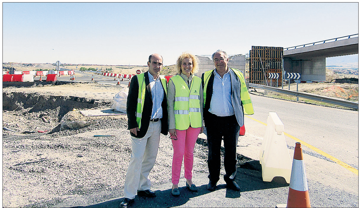
La subdelegada del Gobierno en Segovia, Lirio Martín, en su visita a las obras. / EL ADELANTADO
