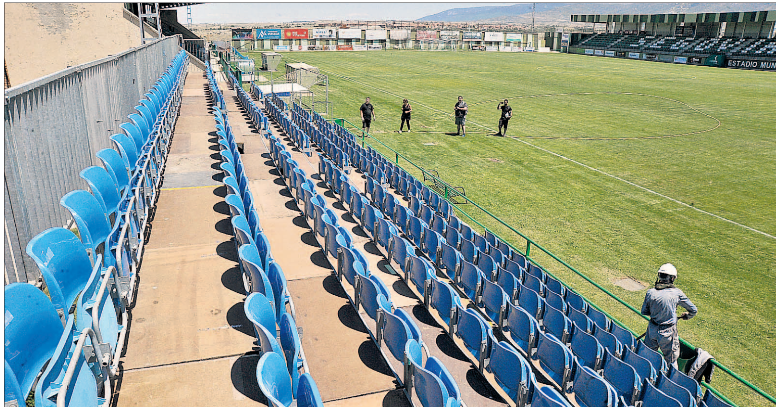
Aspecto del campo de La Albuera, con las gradas supletorias ya instaladas a los lados de la tribuna. / KAMARERO
