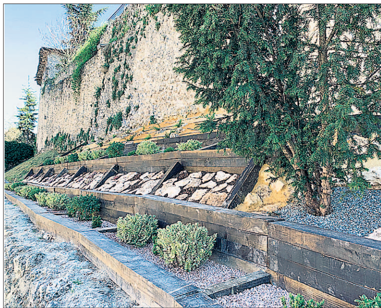
Parte del resultado del talud rehabilitado en la calle Nueva. / C. N.
