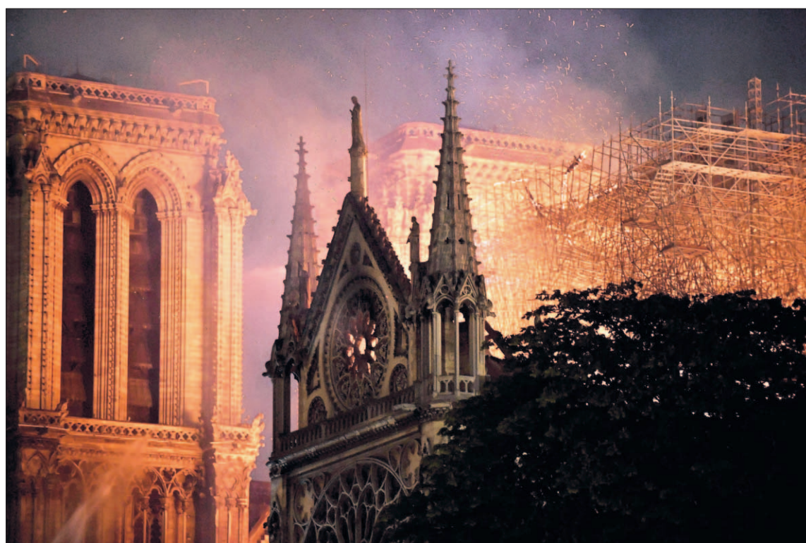
Vista general del incendio que consumió la cubierta de la catedral de Notre Dame. / EFE
