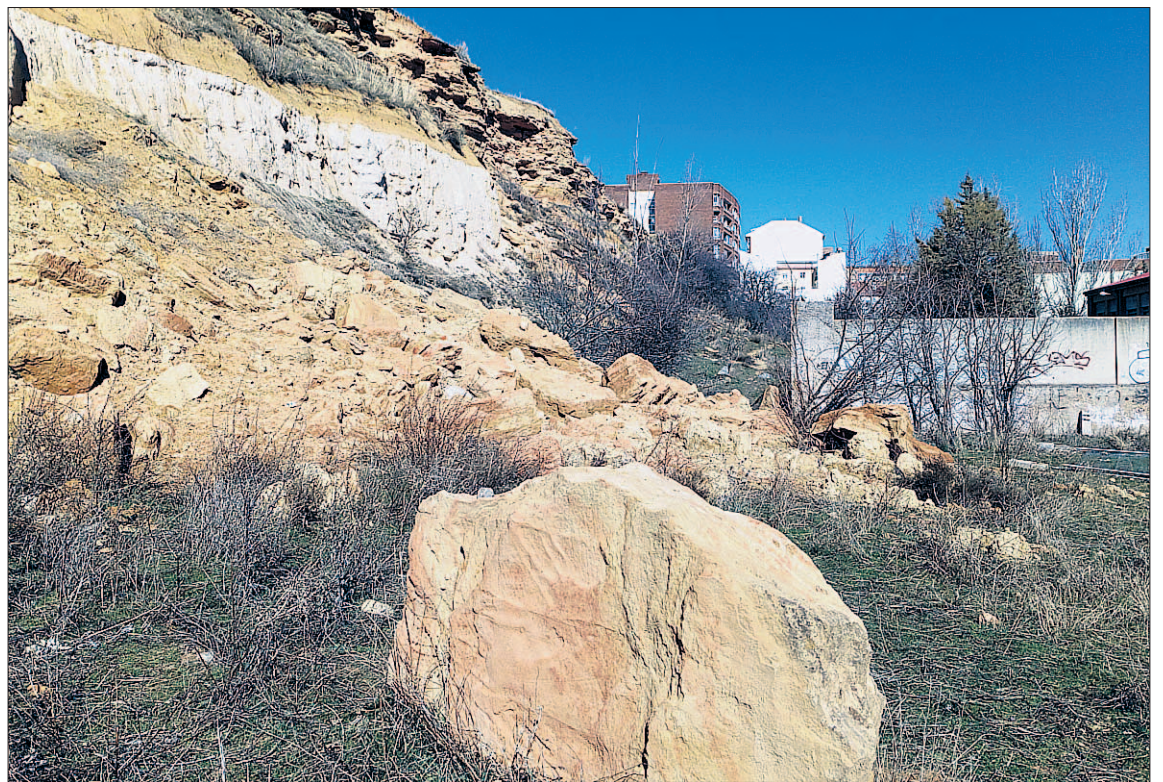
Varias rocas se desprendieron en la zona de Las Lastras hace casi un año y aún siguen presentes en la zona. / EL ADELANTADO
