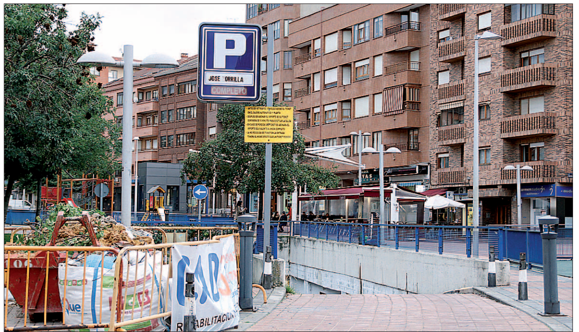
Los operarios continúan trabajando en el aparcamiento de José Zorrilla para acondicionarlo y poder reabrirlo. / N. LLORENTE
