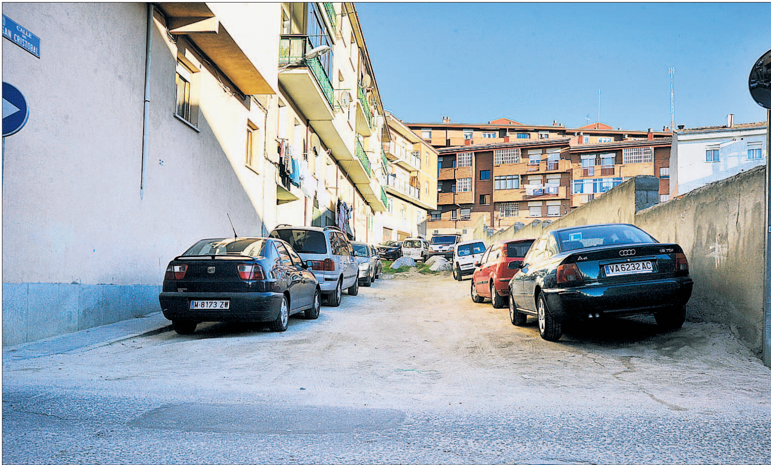
La situación actual de la calle de San Cristóbal, en su tramo superior, obliga a una actuación global que incluirá la demolición de las rocas. / KAMARERO
