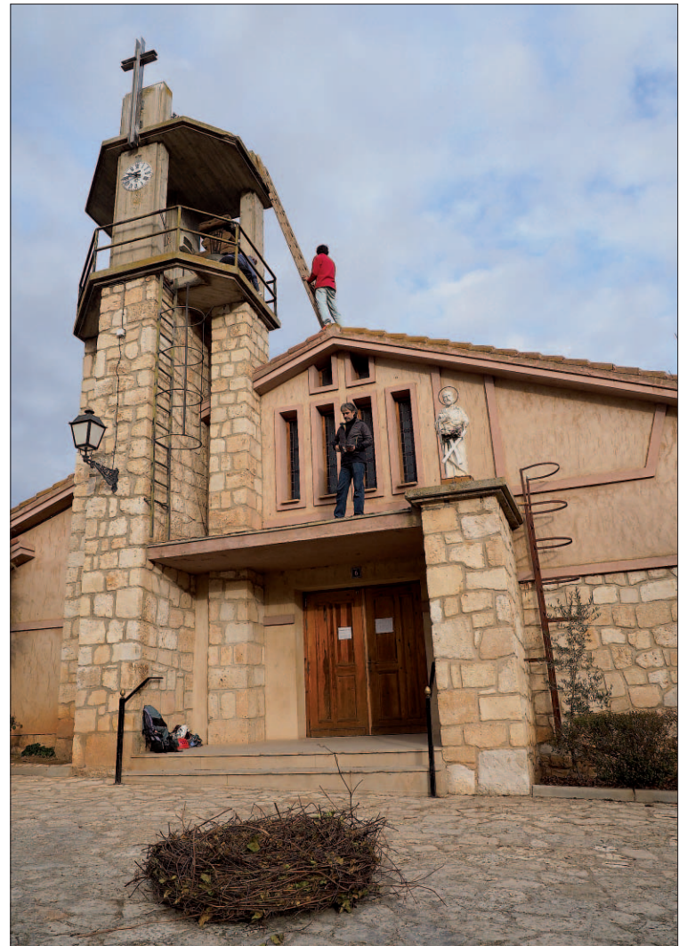
Reponiendo la base del nido de la cigüeña blanca, en Montejo de la Vega. (Fotografía: Juan Carlos Rincón García. 18 de noviembre de 2018).
