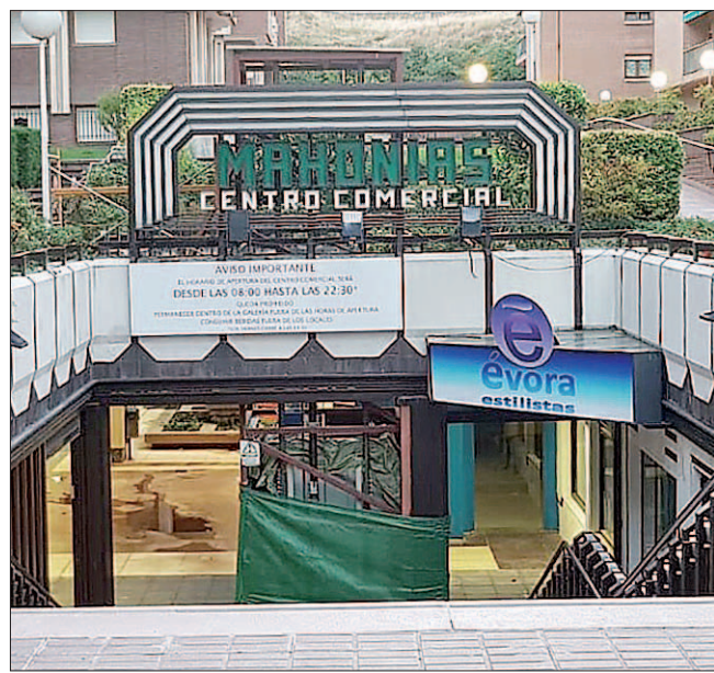
Las galerías del Mahonías actualmente, con solo tres comercios.
