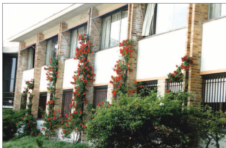
Fachada del nuevo colegio en El Pinarillo.
