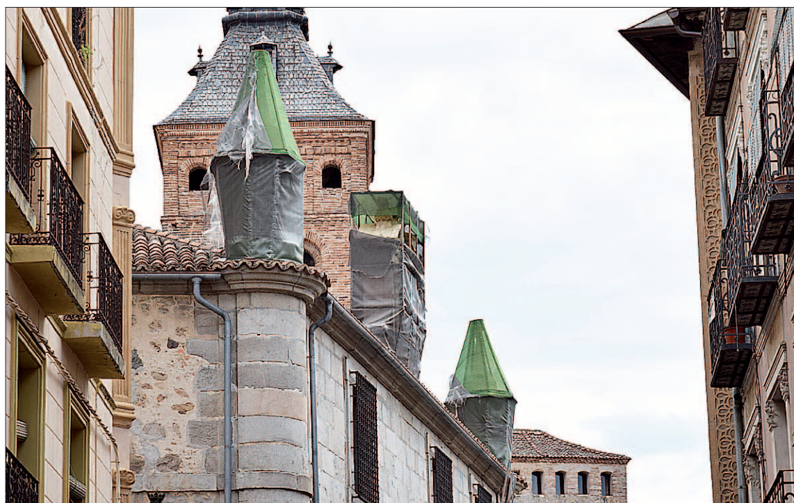
La intervención municipal incluye los pináculos y la espadaña de la cubierta de este edificio del siglo XVI. / ROCÍO PARDOS
