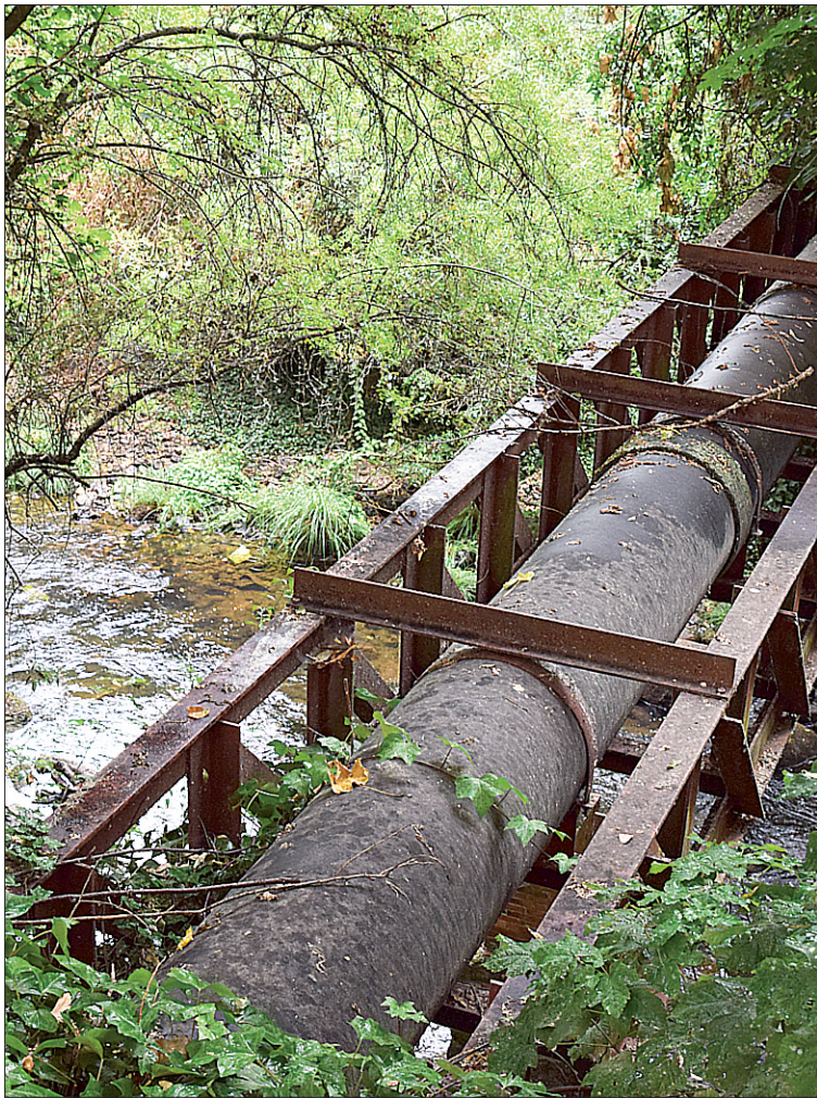
Colector de San Cristóbal de Segovia en la zona del puente de la Loza. / R. PARDOS
