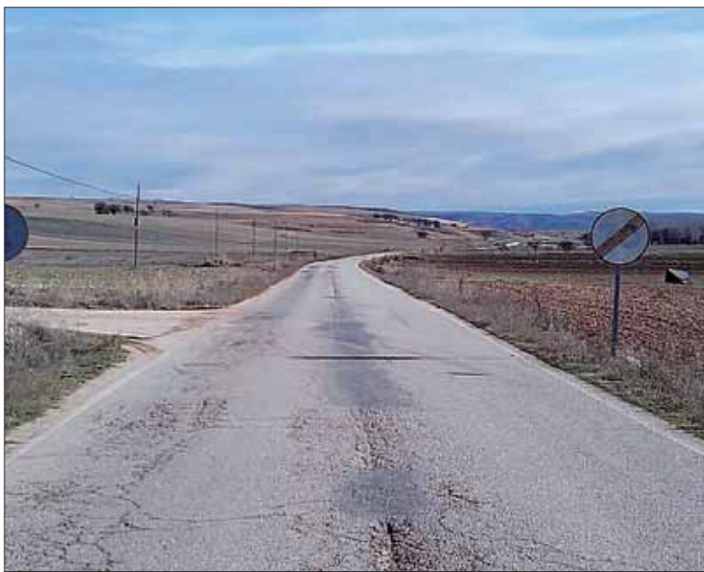
Estado actual de la carretera que hoy se cierra al tráfico. / EL ADELANTADO
