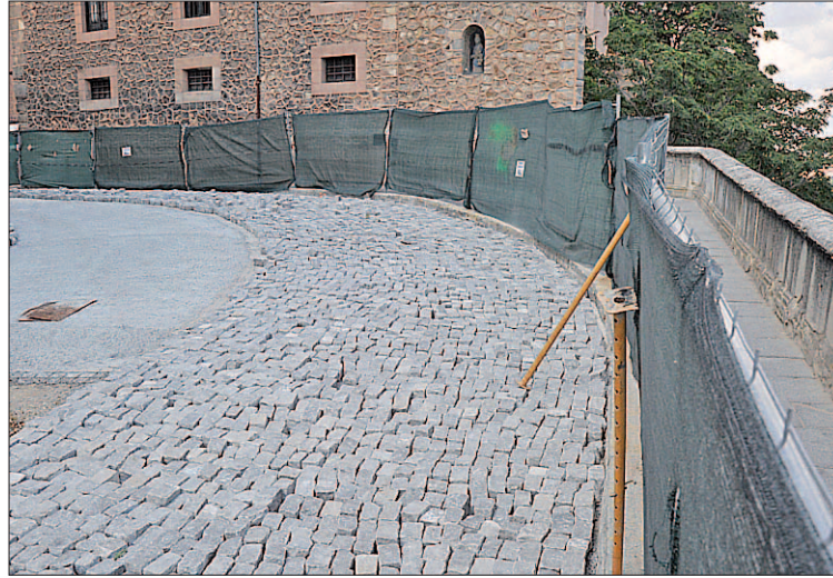
El pavimento de la calzada ya está avanzado, con la colocación de adoquines. / K.
