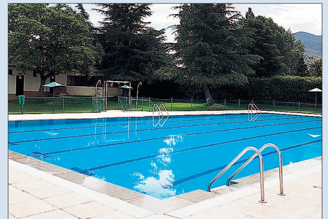
Los vecinos de Otero de Herreros disfrutan ya desde hace unos días de las instalaciones de la piscina municipal, recientemente reformada después de unos veinte años desde que se abrieron. / EL ADELANTADO
