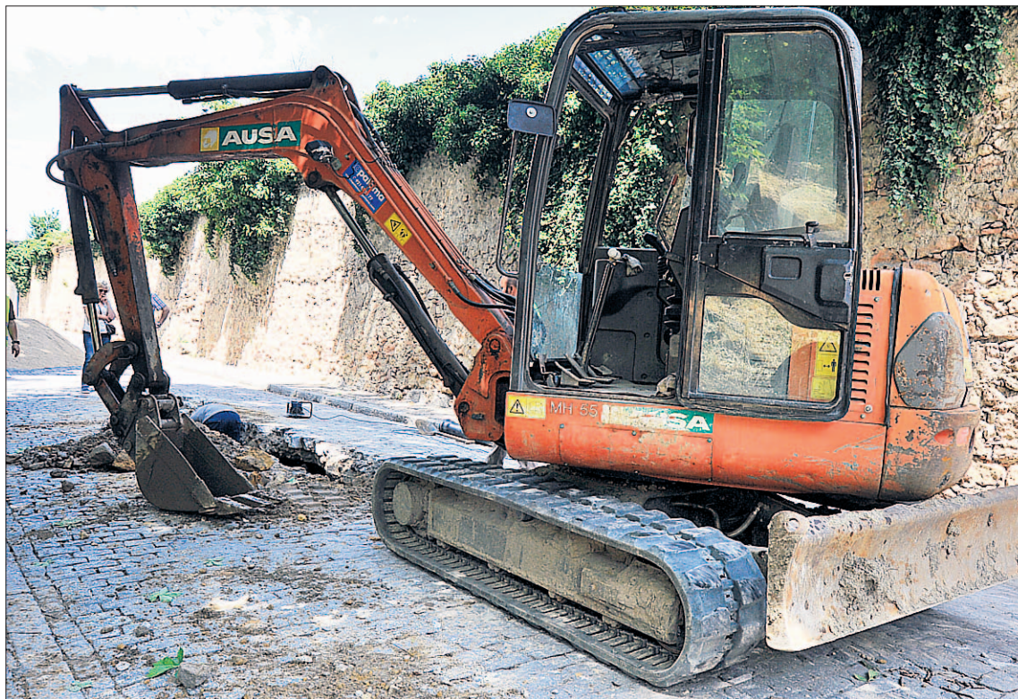
Una máquina excavadora descubre la zona donde se ha localizado la avería de la red de distribución de agua. / KAMARERO
