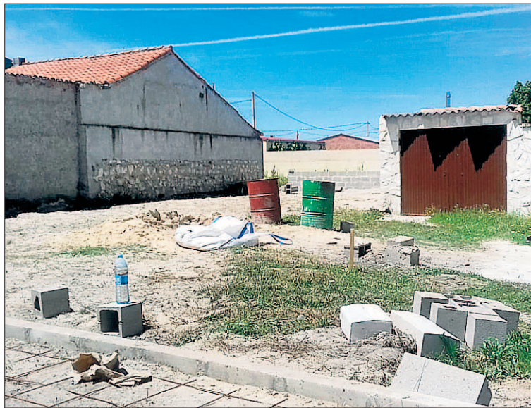
Imagen de la parcela de propiedad privada donde se estarían realizando obras con fondos municipales. / EL ADELANTADO
