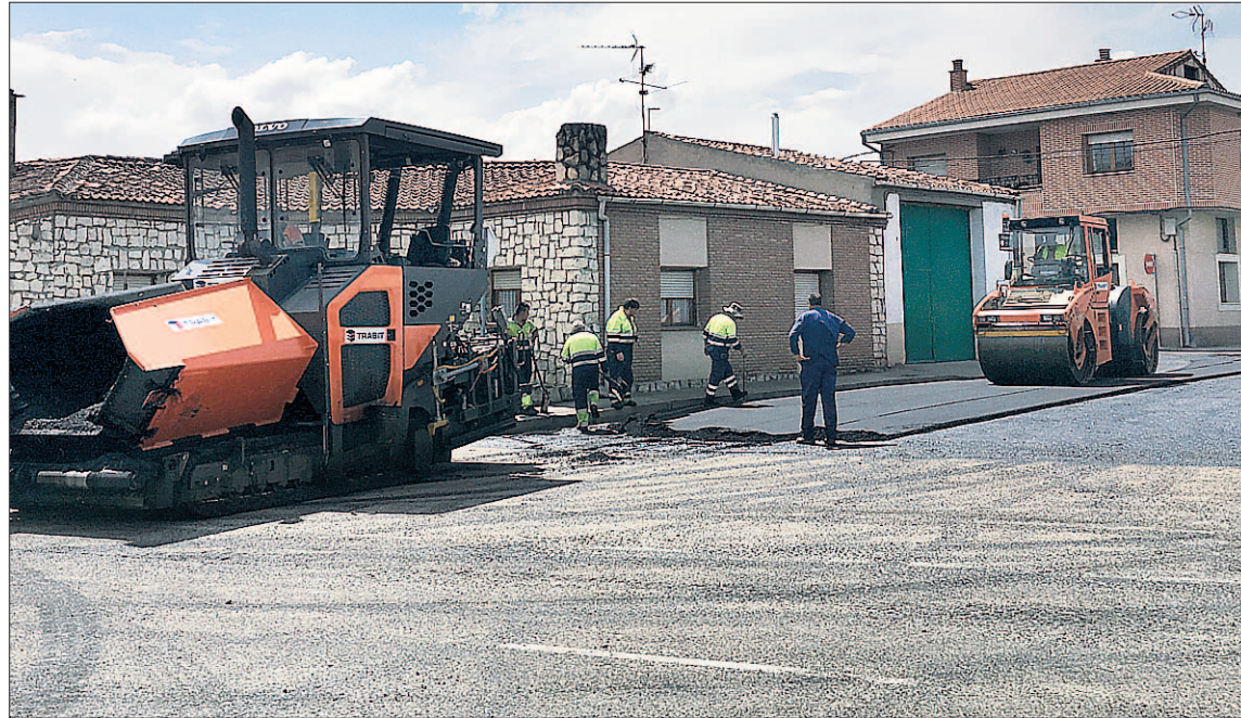
Trabajos de asfaltado en pleno proceso, con toda la maquinaria desplegada./ C.N.
