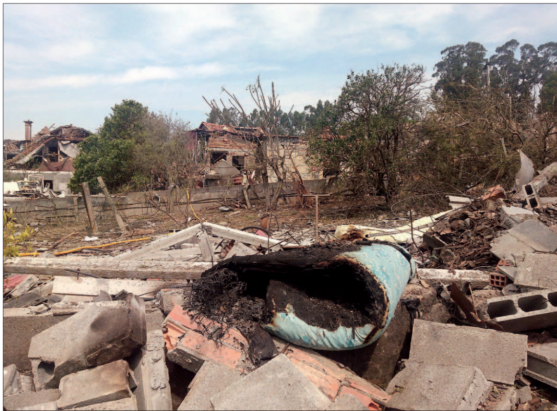
Efectos de la explosión que se produjo ayer en un almacén pirotécnico de Tui, en Pontevedra. / EUROPA PRESS
