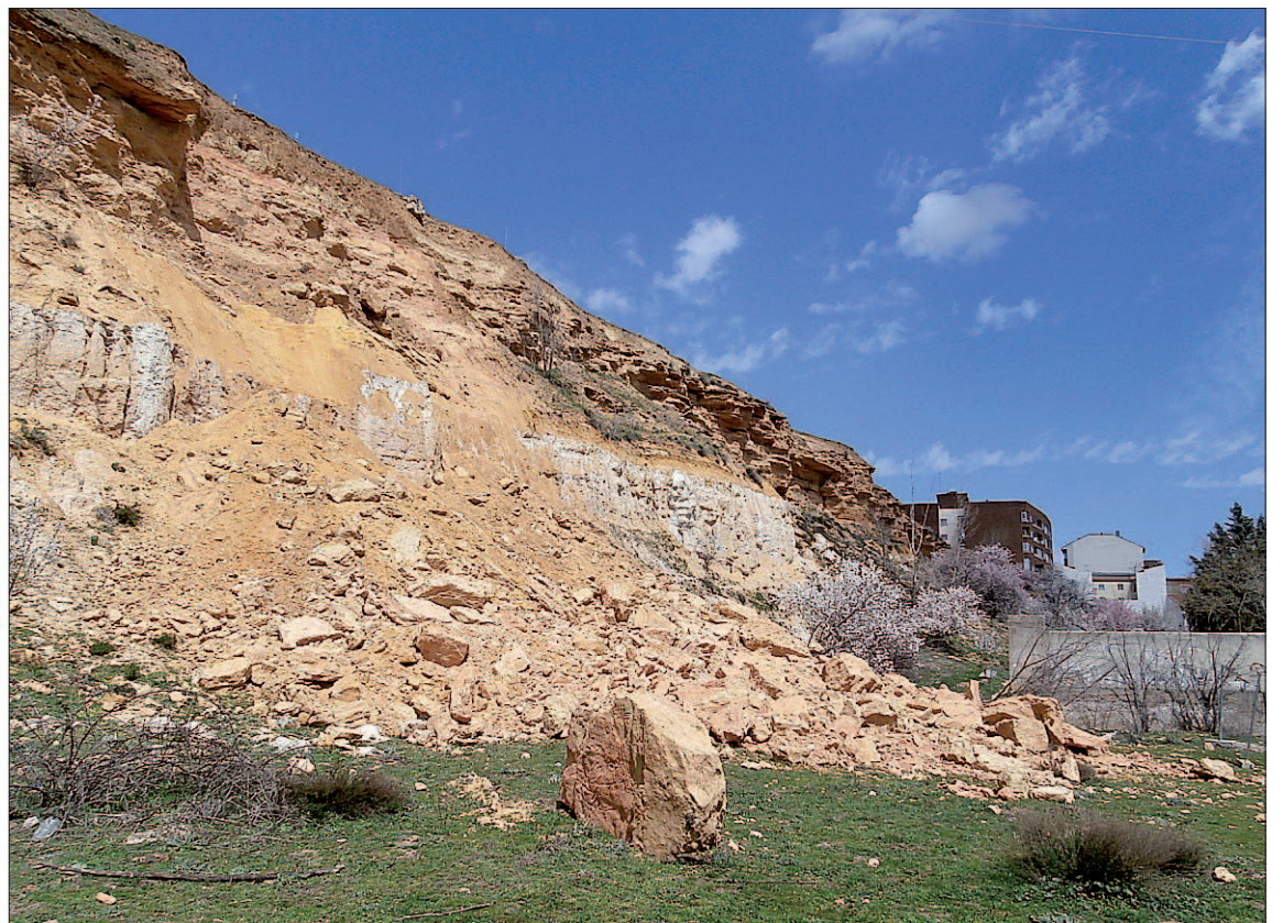
Una avalancha de rocas y tierras ha alcanzado el borde de la valla del colegio y el paseo por Las Lastras en la zona superior. / E. A.
