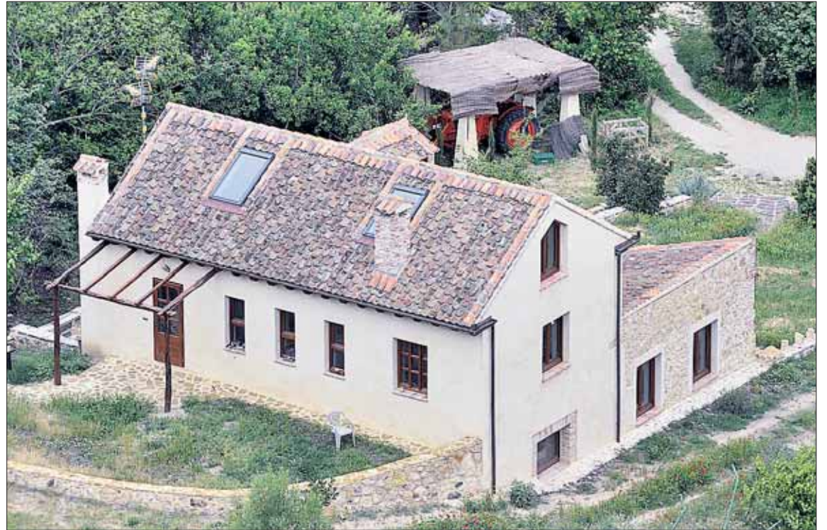
Las obras de rehabilitación de esta vivienda, en una huerta, motivaron el expediente por una infracción urbanística. / K.
