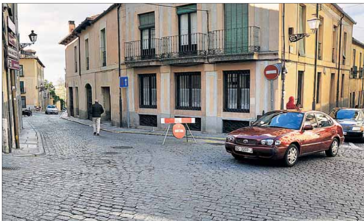
Corte del tráfico en el paseo de San Juan de la Cruz por el inicio de obras de reparación parcial de la calzada. / KAMARERO
