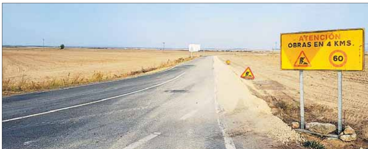
Vista de la carretera de entrada a Escarabajosa de Cabezas, ahora en proceso de ensanche. / EL ADELANTADO
