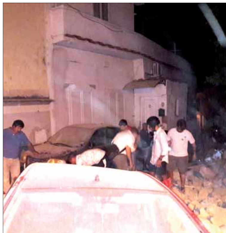
Varios edificios se han derrumbado como consecuencia del seísmo. / EFE
