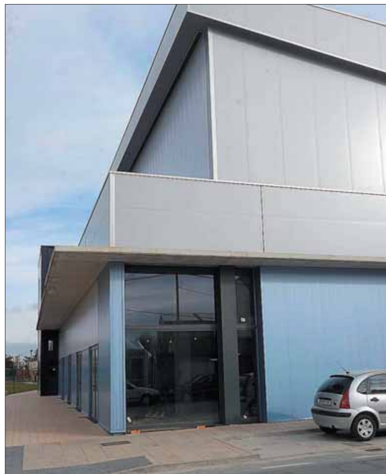
Parte lateral del inacabado pabellón de Nava. / KAMARERO
