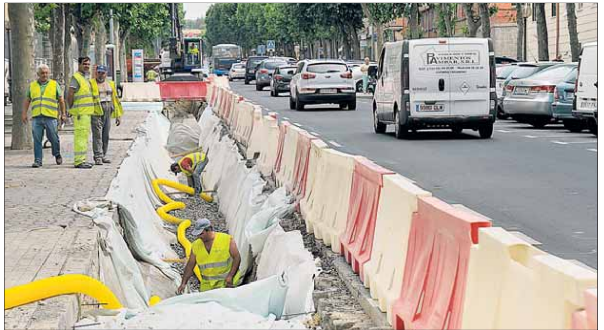
Las obras de la avenida de la Constitución se prolongará todavía hasta finales de este mes de junio. / KAMARERO
