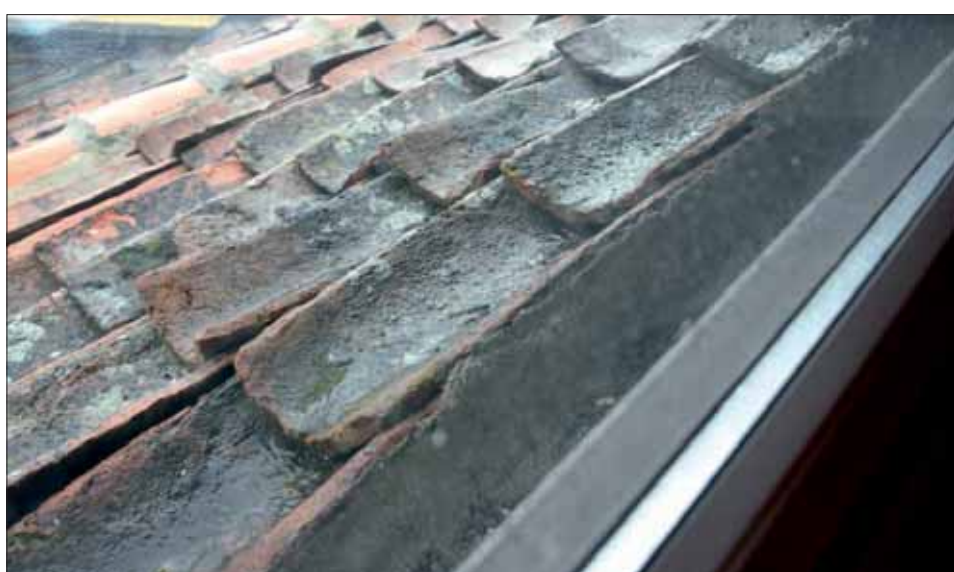
En esta fotografía se puede apreciar que ocurre cuando llueve sobre un tejado a la segoviana, el agua de toda la superficie de la teja, debido a su concavidad se canaliza hacia el centro de la teja, desde donde van canalizándose hacia el alero.
