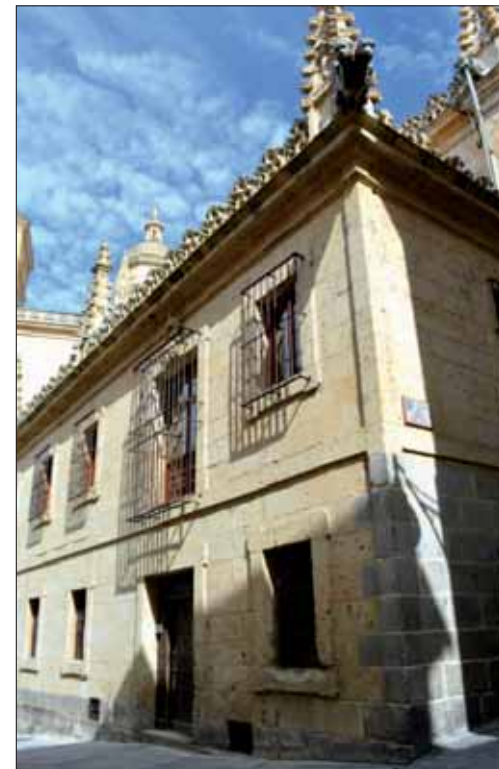
Edificio donde sitúa el Archivo de la Catedral de Segovia.
