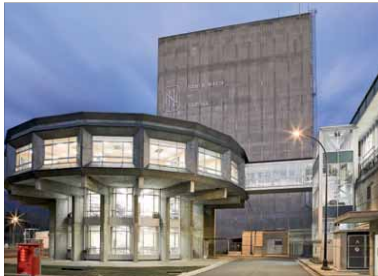
Exterior de la central nuclear de Santa María de Garoña. / EUROPA PRESS
