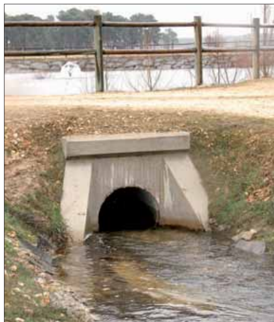
Una de las balsas de esta presa.
