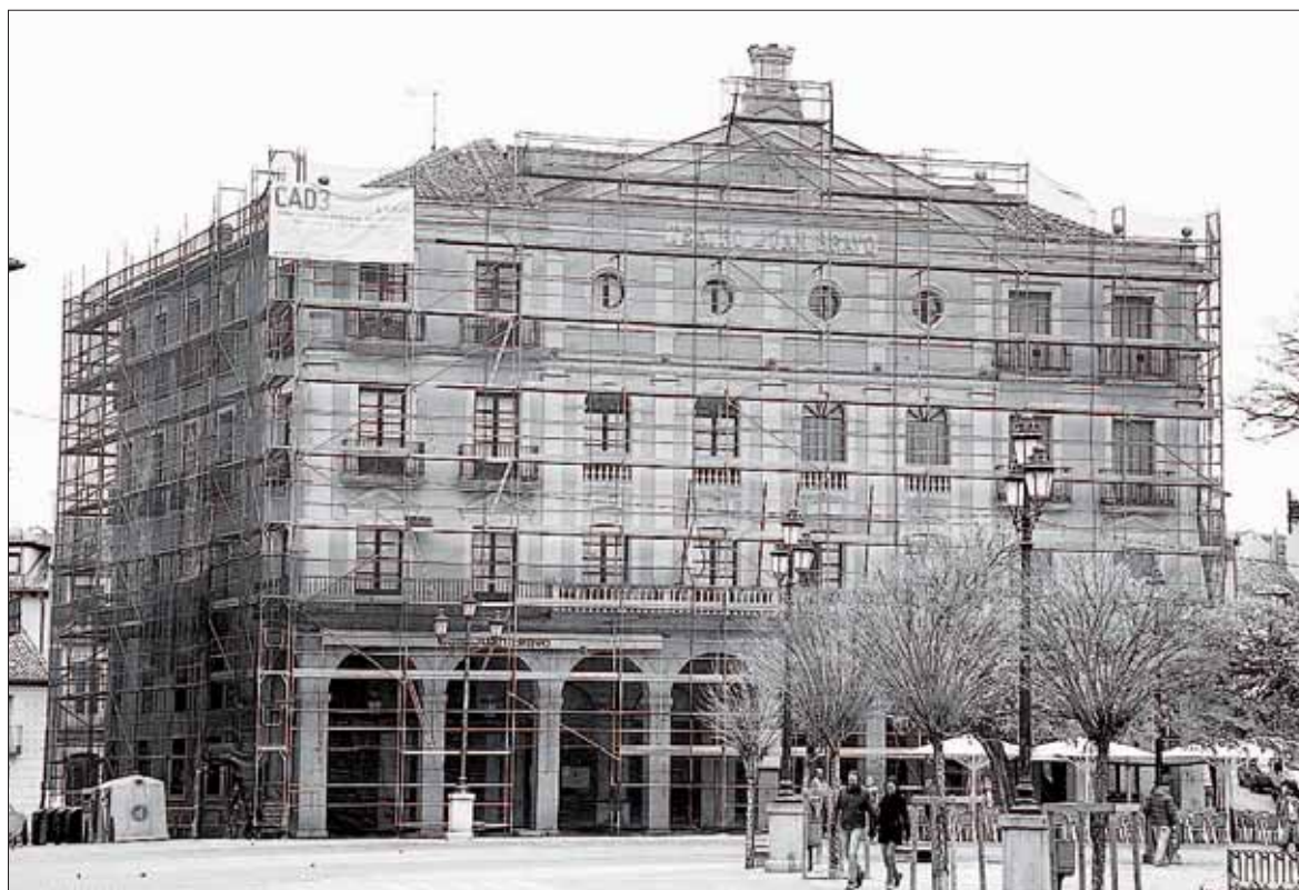
La remodelación del Teatro Juan Bravo será la obra de mayor calado de la Diputación en 2017. / KAMARERO
