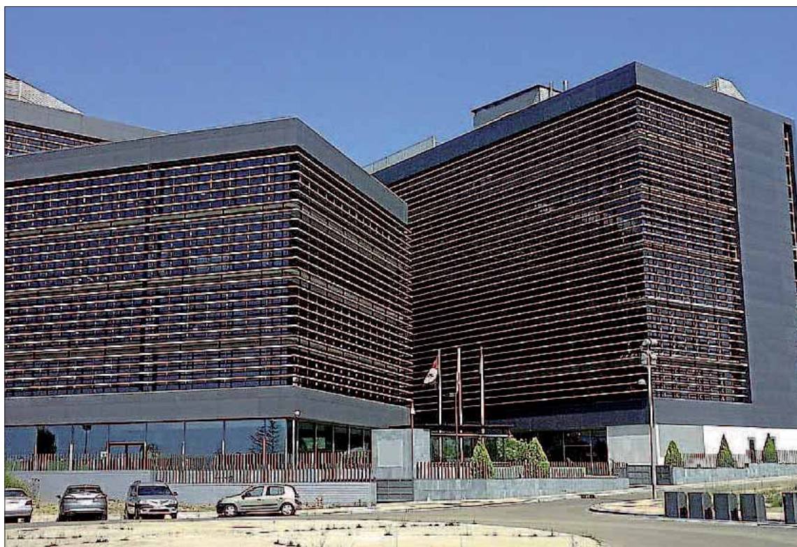
Edificio de Soluciones Empresariales de Arroyo de la Encomienda, en la provincia de Valladolid. / EUROPA PRESS
