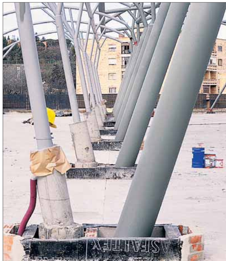
Detalle de los anclajes de la estructura metálica de la estación. / KAMARERO
