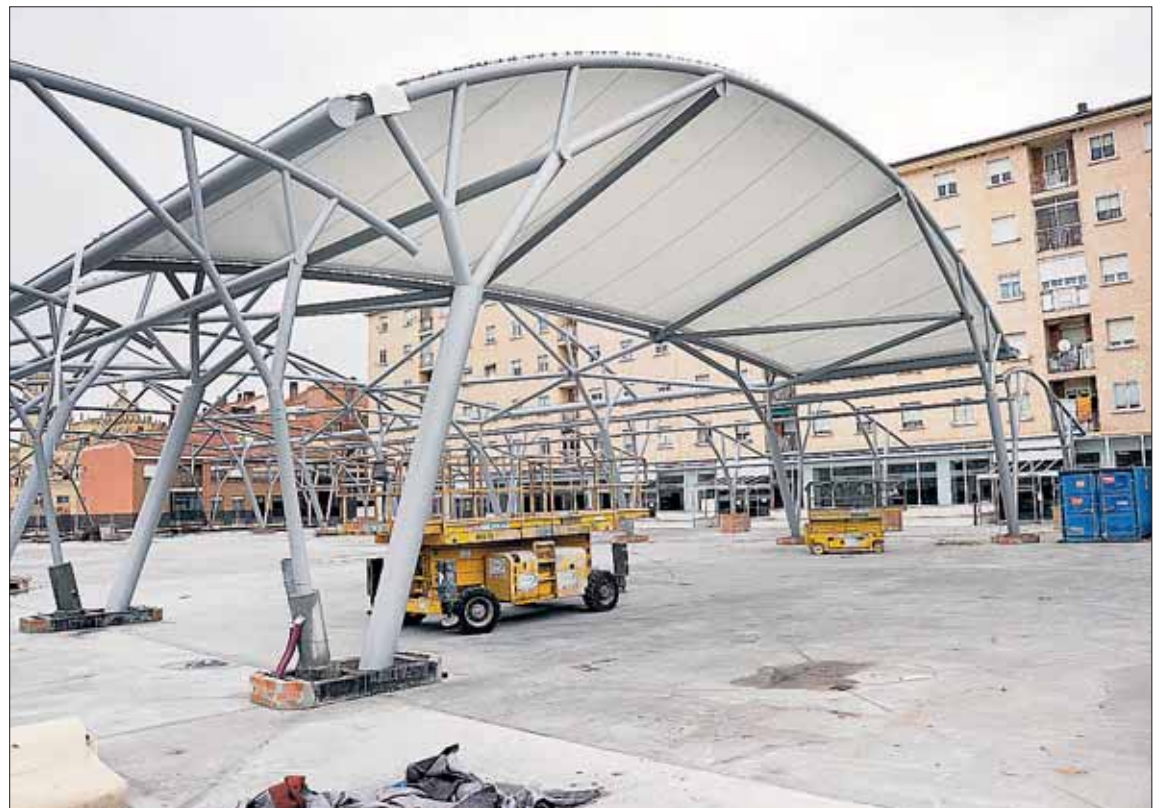
Una parte de la estructura metálica cuenta ya con cubierta textil tensada. / KAMARERO
