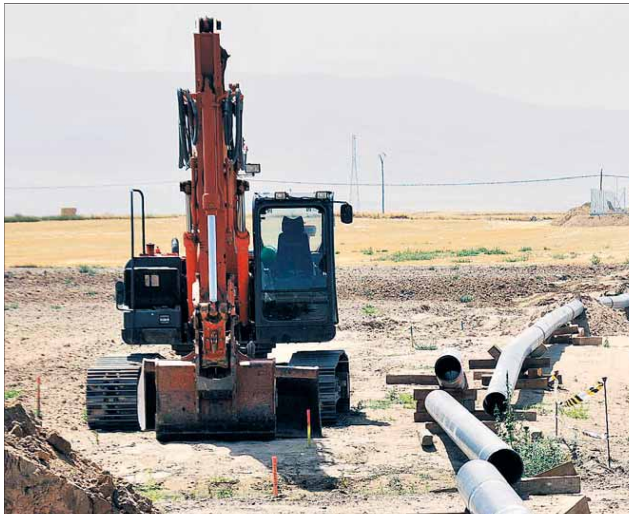
En los últimos años es frecuente ver esta imagen en la provincia, con la ejecución de los ramales para llevar al gas a las viviendas y empresas
