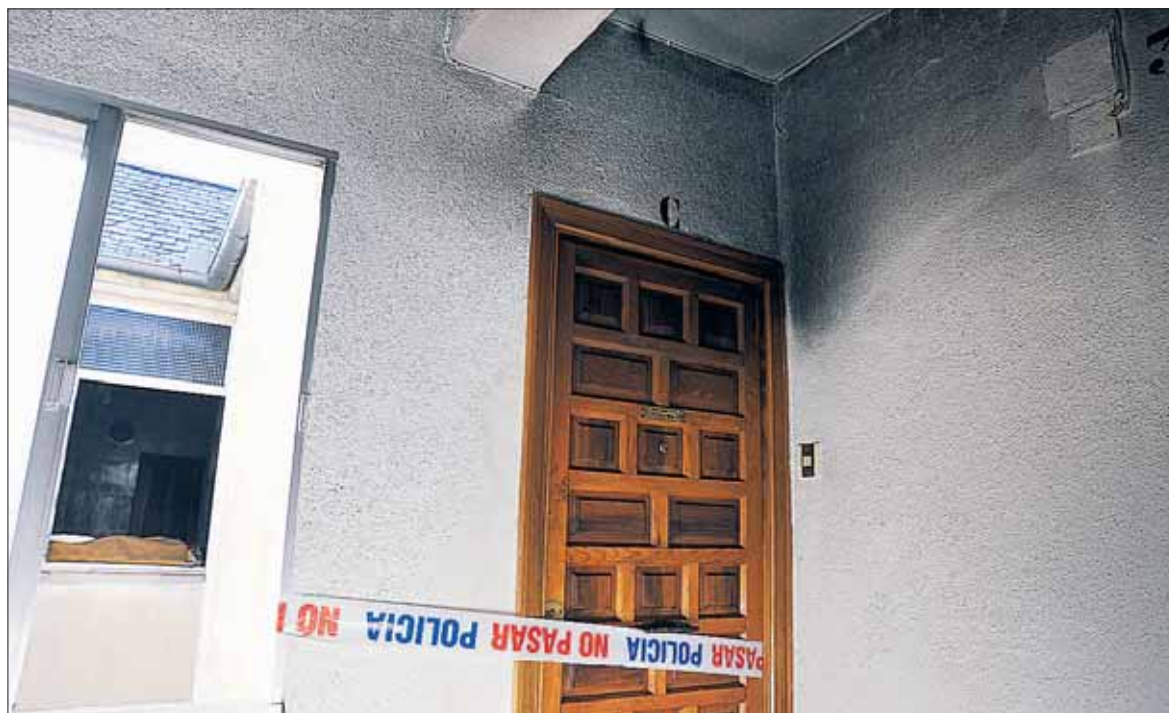
La Policía precintó el acceso a la vivienda afectada, en el tercer piso de un edificio de la calle Londres. / KAMARERO
