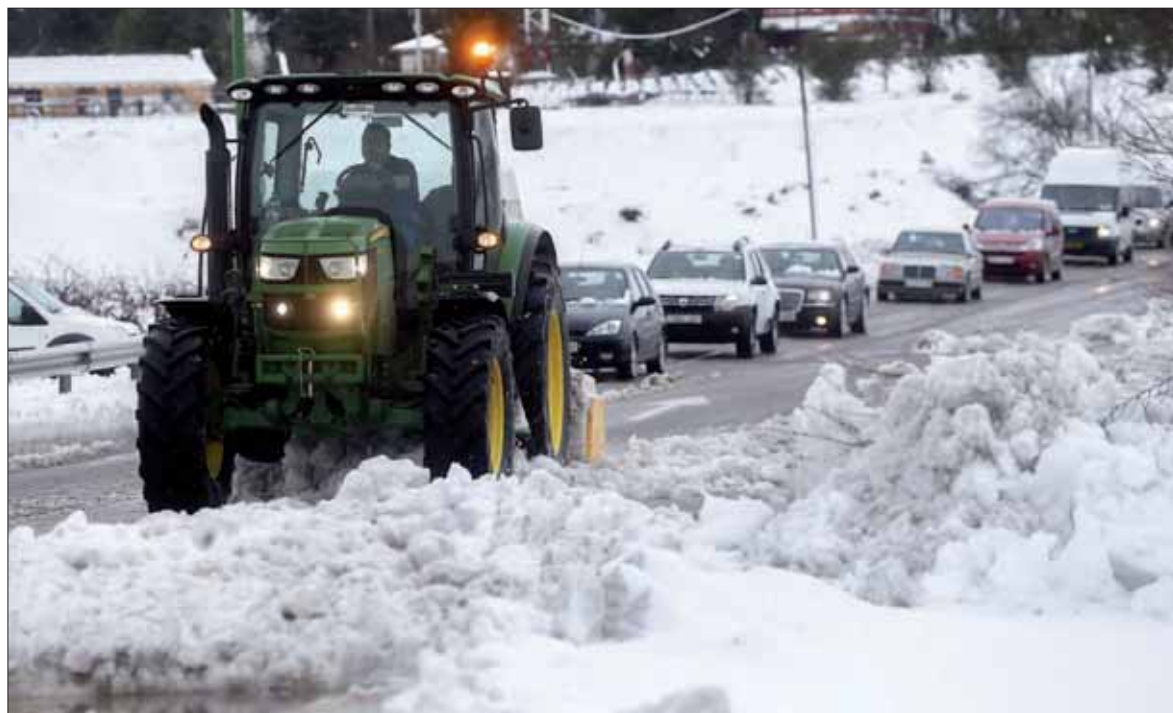
Un tractor limpia un acceso a la A-3 a la altura de Requena (Valencia) tras ser reabierto al tráfico. / EFE
