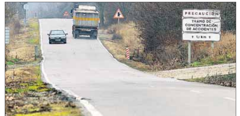
Un cartel avisa de un tramo especialmente peligroso en la carretera. / KAMARERO
