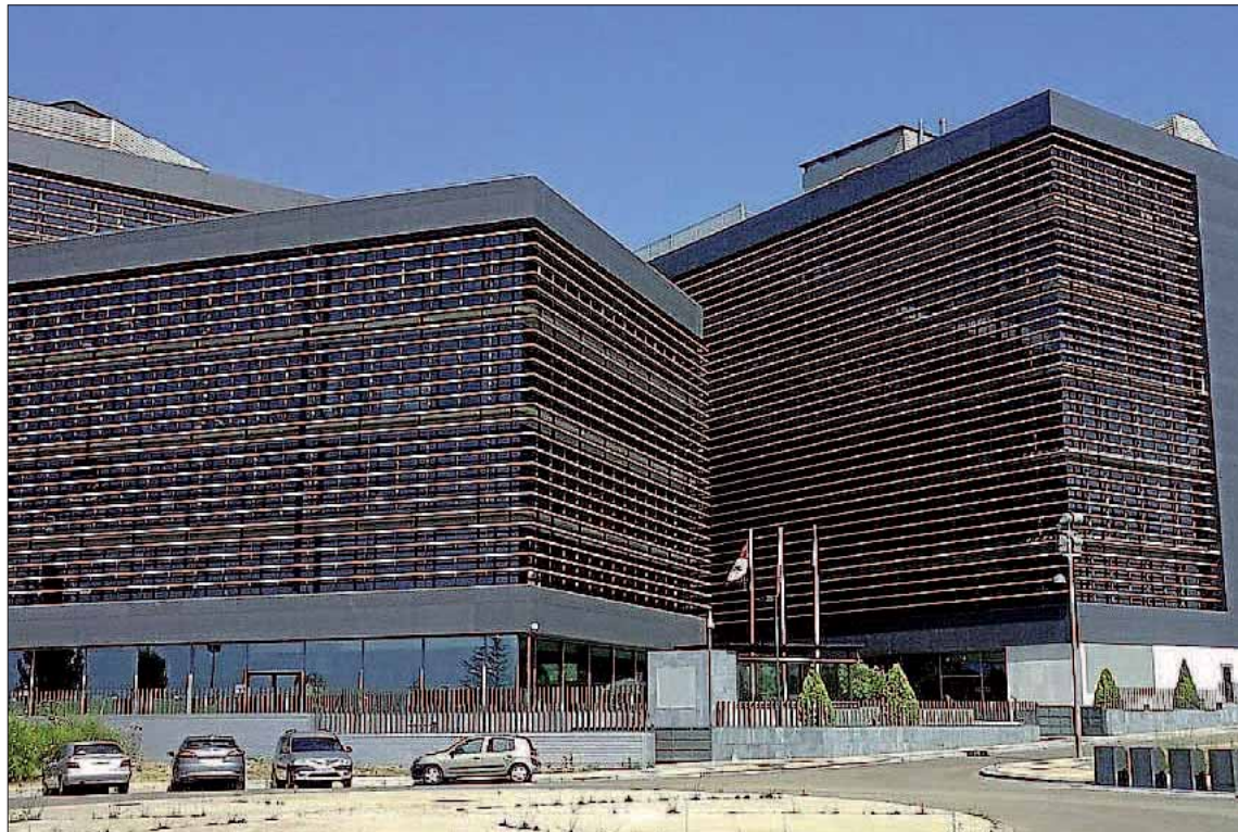
El edificio de Soluciones Empresariales de Arroyo de la Encomienda, cuya compra dio lugar al presunto delito. / E.P.
