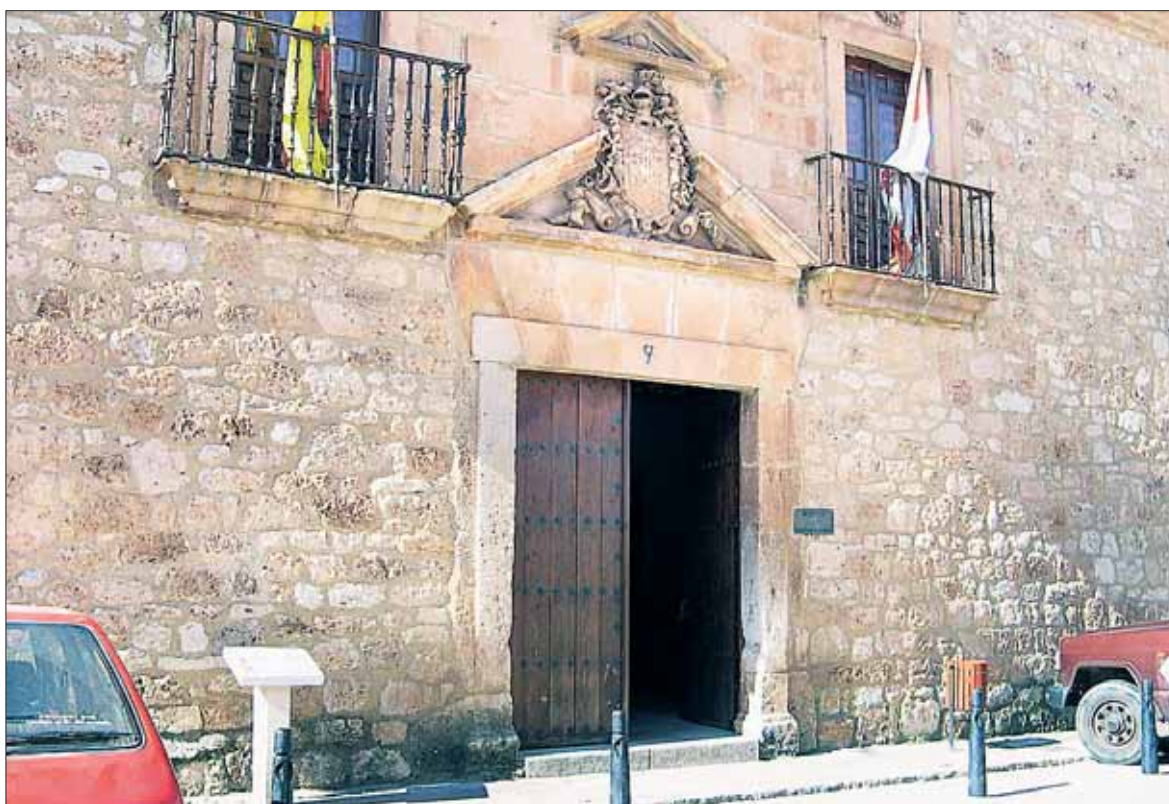
Portada del palacio (antes de ser apuntalado) que mandó construir Fernando de Vellosillo, siendo obispo de Lugo./ M. COCO
