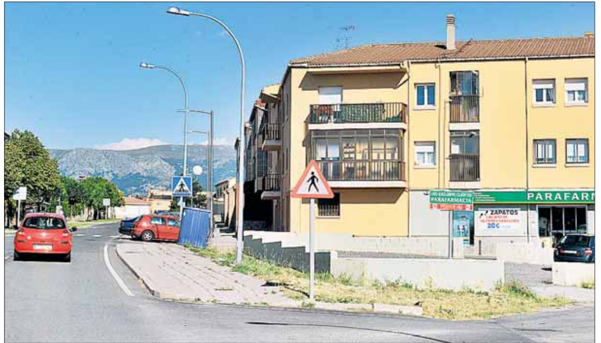
Los edificios de Palazuelos de Eresma tendrán que someterse a una inspección técnica. / KAMARERO
