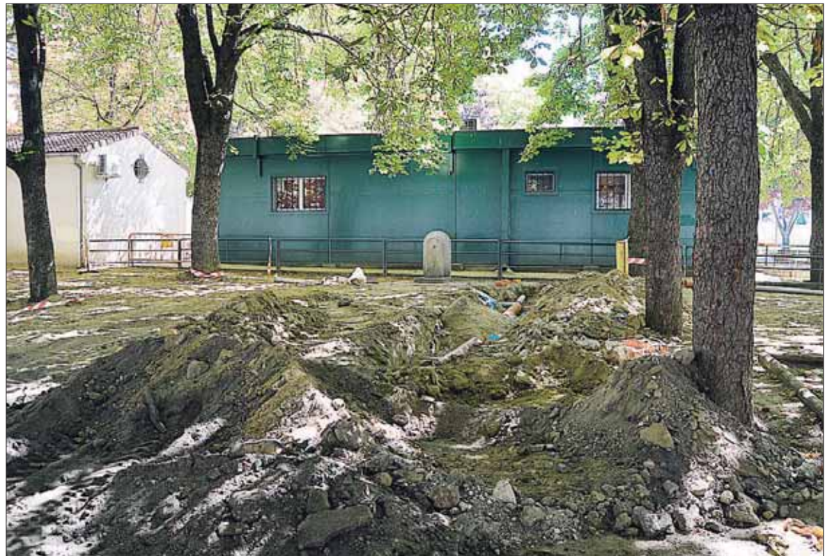
Imagen que presentaba ayer la arboleda del Parque Infantil de Tráfico donde se están cambiando tuberías. / CRISTINA YUSTA
