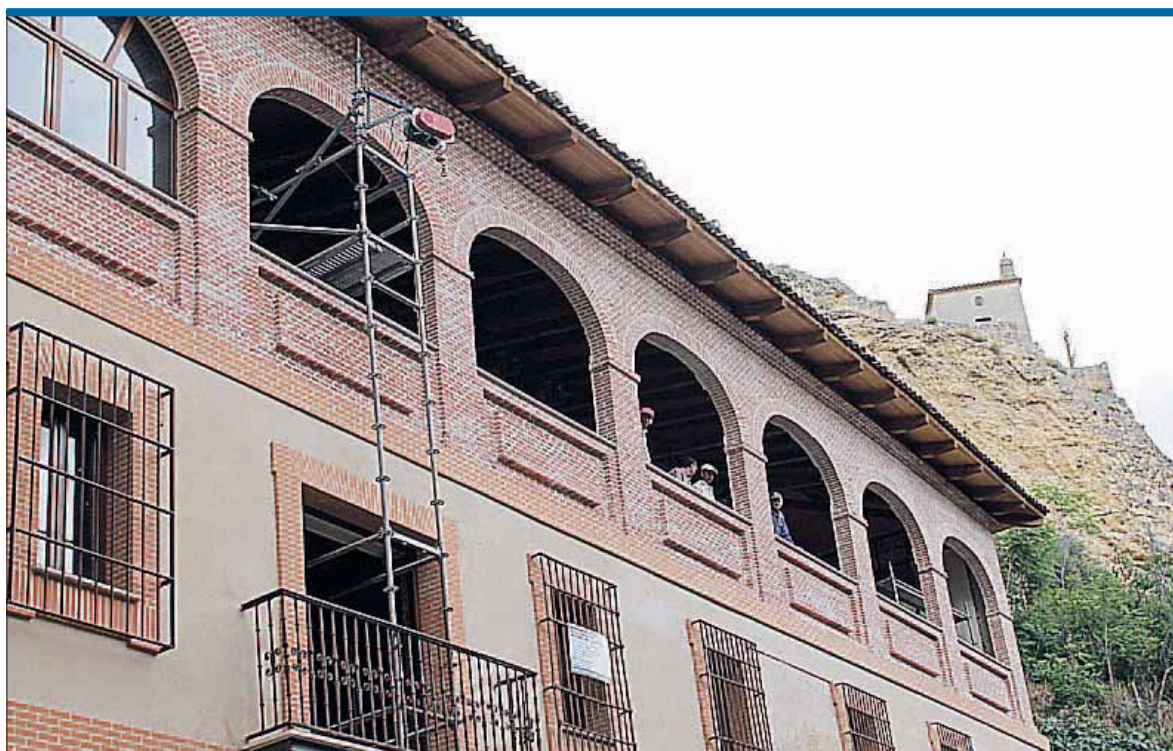
Comienzan las obras en la casa rectoral de La Fuencisla. Los trabajos de reacondicionamiento de la cubierta de la casa rectoral del santuario de Nuestra Señora de la Fuencisla han dado ya comienzo con la retirada de los ventanales y el inicio de los trabajos de albañilería interior. Las obras serán sufragadas por el obispado de Segovia y tendrán un presupuesto de 35.000 euros. / FOTO: M.G.
