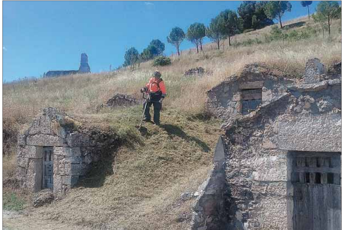
Las cuadrillas de obreros están realizando maniobras de desbroces, clareos y podas en zonas periurbanas. / EL ADELANTADO
