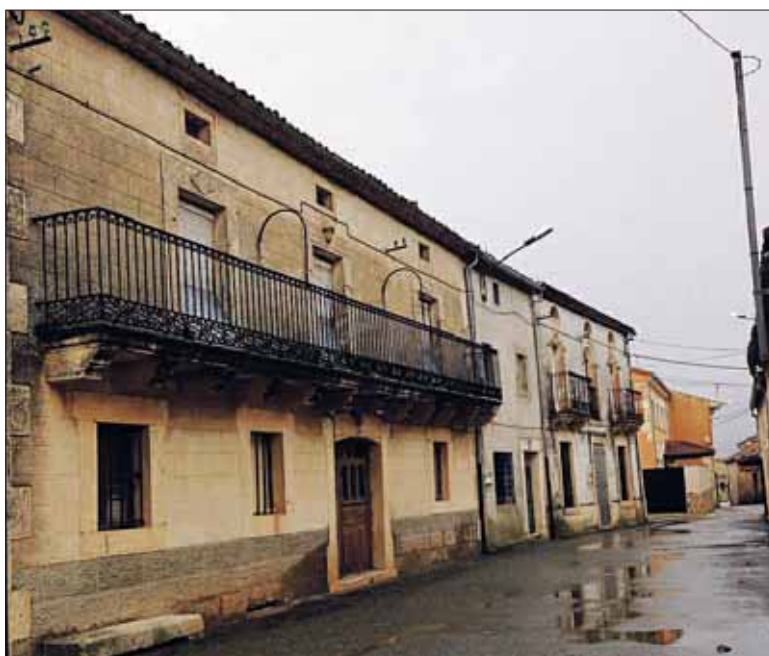
Edificios de Navares de Enmedio, municipio adherido al servicio. / E. A.
