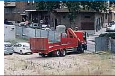
Instalación de las casetas de obras en el solar de la UVa
