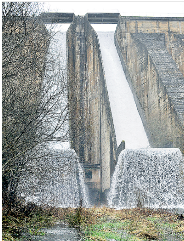
El proyecto de recrecida del embalse de Puente Alta ha sido descartado. / KAMARERO
