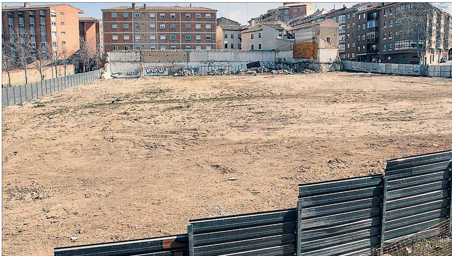
Los terrenos ya explanados están listos para recibir las máquinas y dar comienzo a la construcción del nuevo edificio. / JUAN MARTÍN
