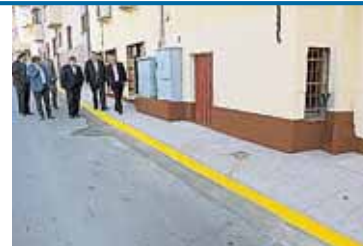
Un momento de la visita de la corporación municipal a las obras
