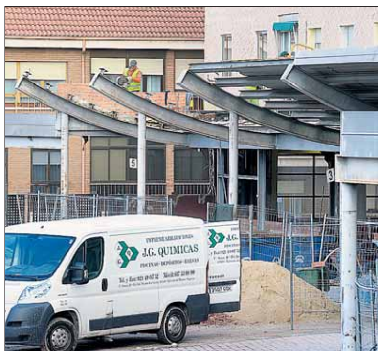
Estructura metálica de la marquesina que ha sido retirada de la terminal. / KAMARERO
