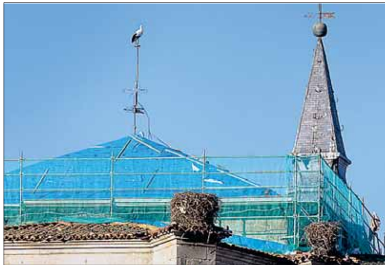
A pesar de las obras, las cigüeñas siguen posándose en la iglesia. / PEDRO MERINO
