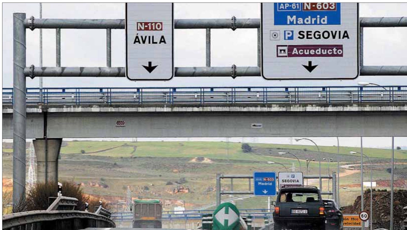
Las obra para el desdoblamiento de la SG-20 (en la imagen) se prolongarán por espacio de tres años. / JUAN MARTÍN
