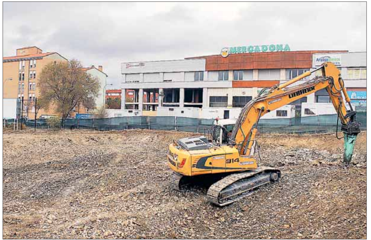
La nueva instalación comercial se contruye ante la fachada del supermercado inaugurado en mayo de 2003. / M. GALINDO
