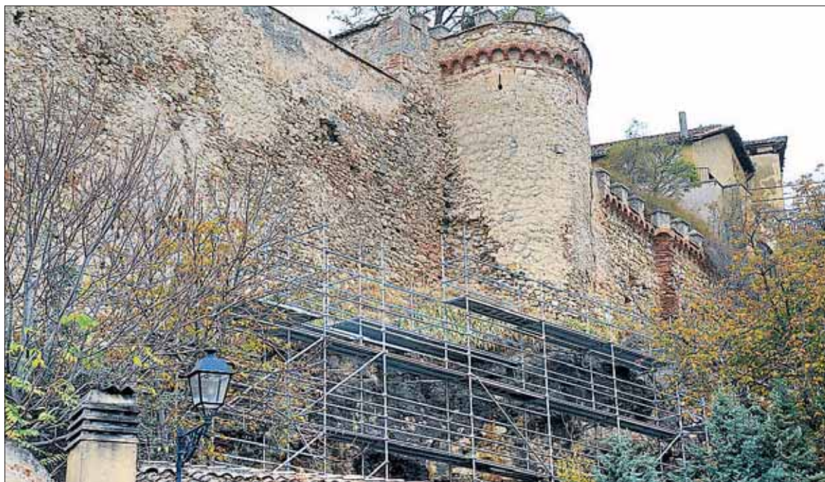
Los andamios ya cubren el tramo de la muralla, próximo a la calle de San Millán, que será restaurado. / KAMARERO
