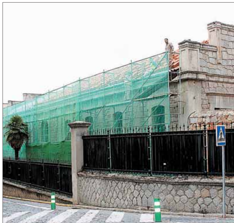
Los trabajos se prolongarán al menos hasta la primavera de 2016. / M.G.
